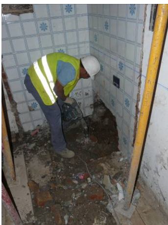
29. Excavació manual de l'encepat 4. Des del sud.
