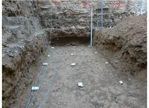
34. Vista final de la rasa de fonamentació. Des del sud-oest.
