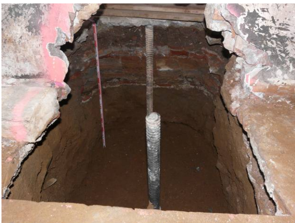
17. Vista final de l'encepat 5. Vista des de l'oest.
