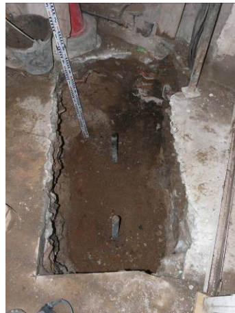
28. Vista final de l'encepat 10. Des del sud-oest.
