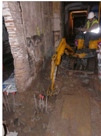
52. Excavació mecànica de la riosta 4.1.
