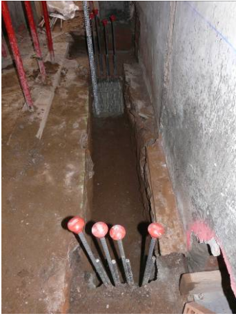
43. Vista final de la riosta 2.2. Des del sud-est.
