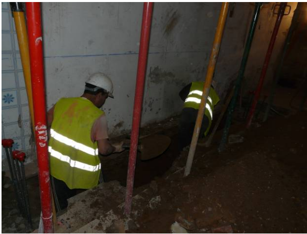
49. Excavació manual de la riosta 3.2.
