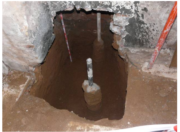
20. Vista final de l'encepat 6. Vista des de l'oest.
