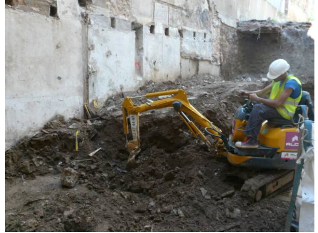
2. Rebaix mecànic del terreny de la zona del pati. Vista des del sud.
