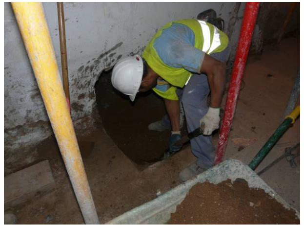
32. Excavació manual de l'encepat 5.
