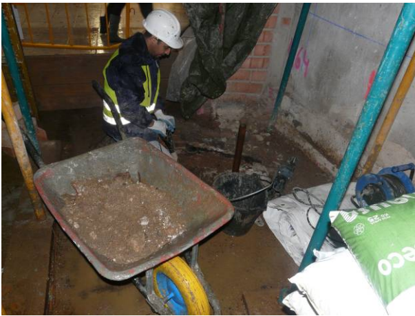
31. Excavació manual de l'encepat 9.
