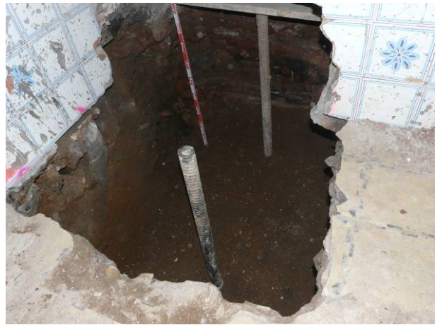
14. Vista final de l'encepat 4. Vista des del sud-est.
