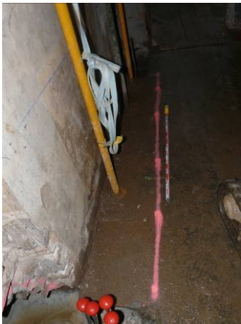
39. Vista inicial de la riosta 2.1. Des del sud-est.
