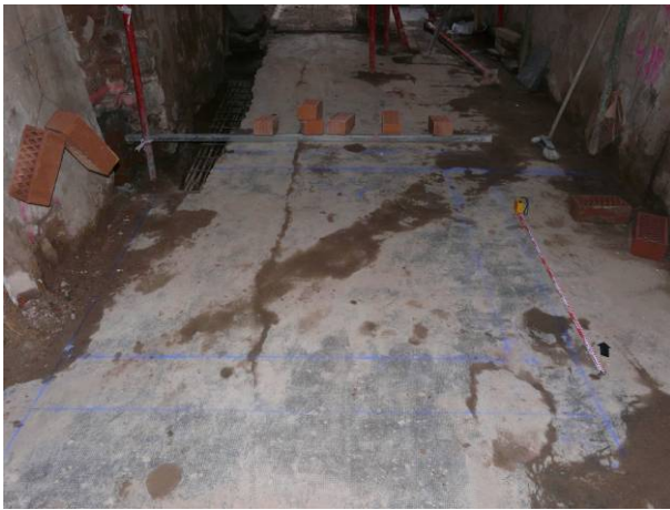
55. Vista inicial del fossat d'ascensor. Des del sud-est.
