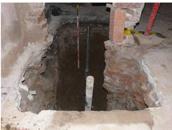
5. Vista final de l'encepat 1. Vista des de l'oest.
