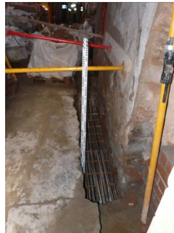
40. Vista final de la riosta 2.1. Des del nord-est.
