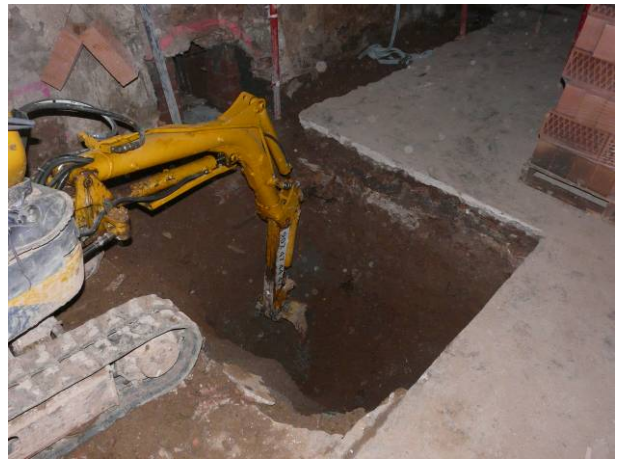
56. Excavació mecànica del fossat d'ascensor.
