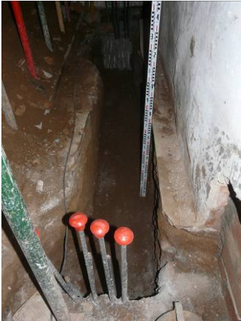
45. Vista final de la riosta 3.1. Vista des del nord-oest.
