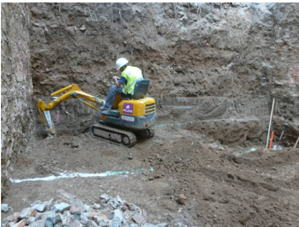
35. Excavació mecànica de la rasa de fonamentació.
