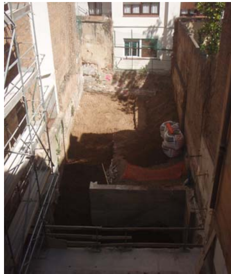
62. Vista general de la zona del pati.
