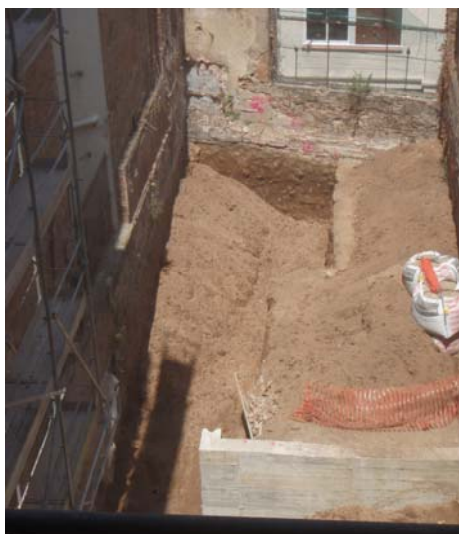
67. Vista general un cop finalitzats els treballs.
