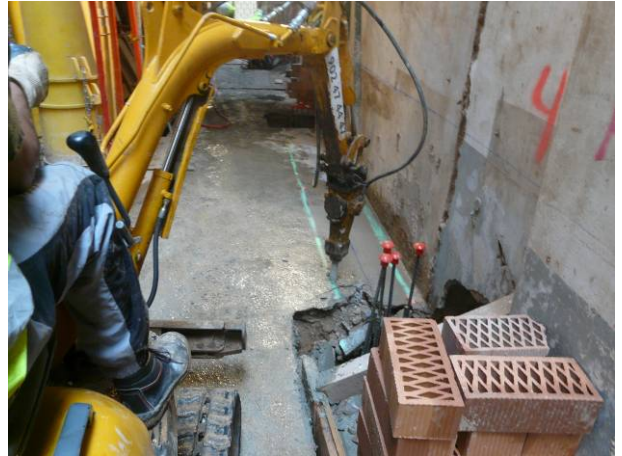
46. Excavació mecànica de la riosta 3.1. Vista des del nord-oest.
