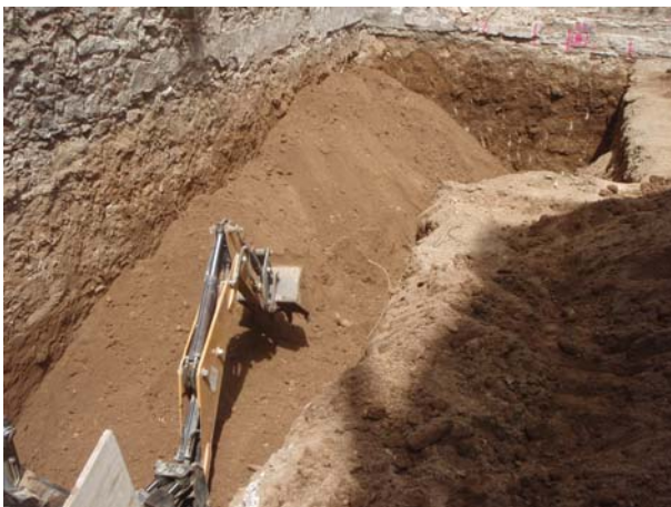
65. Finalització dels treballs de rebaix del pati
