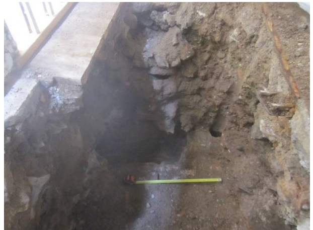
58. Vista final de la riosta 5. Vista des de l'est.
