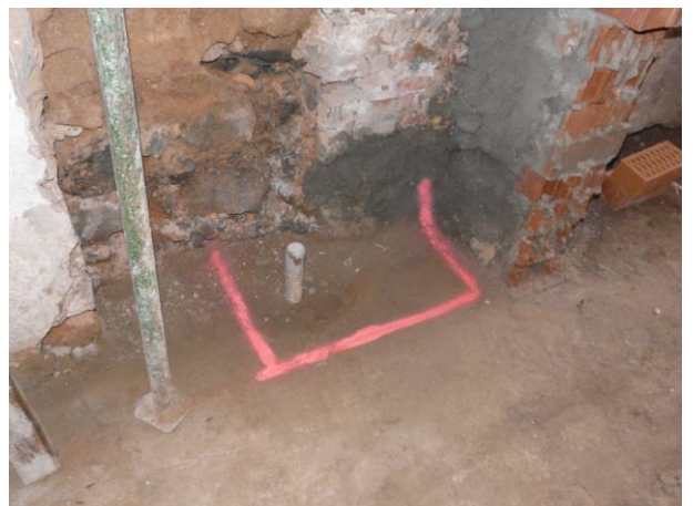
18. Vista inicial de la part oriental de l'encepat 6. Vista des del sud-est.
