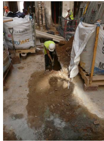
38. Excavació manual de la riosta 1. Des del nord-est.
