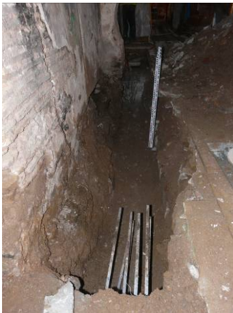
51. Vista final de la riosta 4.1. Des del sud-est.
