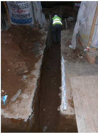
37. Vista final de la riosta 1. Des del sud-est.
