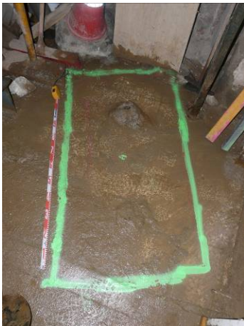
27. Vista inicial de l'encepat 10. Des del sud-oest.
