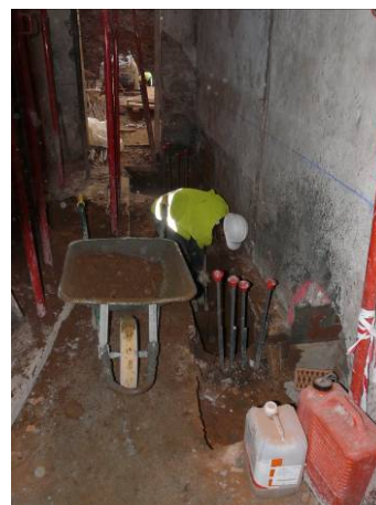
42. Excavació manual de la riosta 2.2. Des del sud-est.
