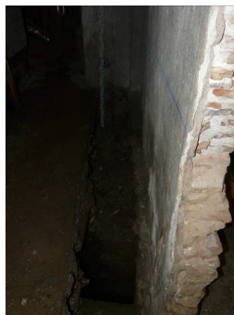
54. Vista final de la riosta 4.2. Des del sud-est.
