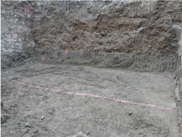
33. Vista inicial de la rasa de fonamentació al pati, un cop rebaixat el terreny fins a la cota contemplada al projecte d'obres.
