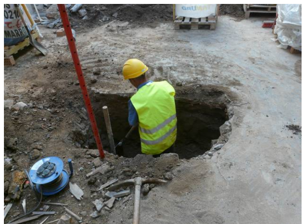
30. Excavació manual de l'encepat 7. Des del nord-est.
