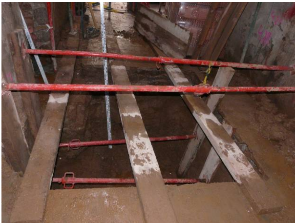
57. Vista final del fossat d'ascensor. Des del sud-est.
