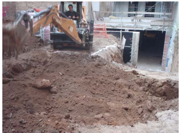
60. Inici dels treballs de rebaix del pati.
