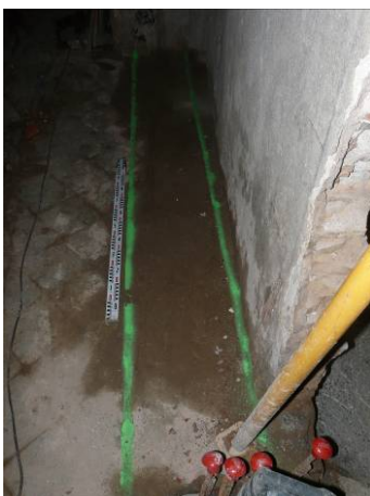
53. Vista inicial de la riosta 4.2. Des del sud-est.
